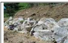
▶ (사면 및 암반) 굴착 사면의 적정 기울기를 준수하지 않고 작업 중 토사가 무너지면서 사면 및 암반 더미에 깔려 사망
